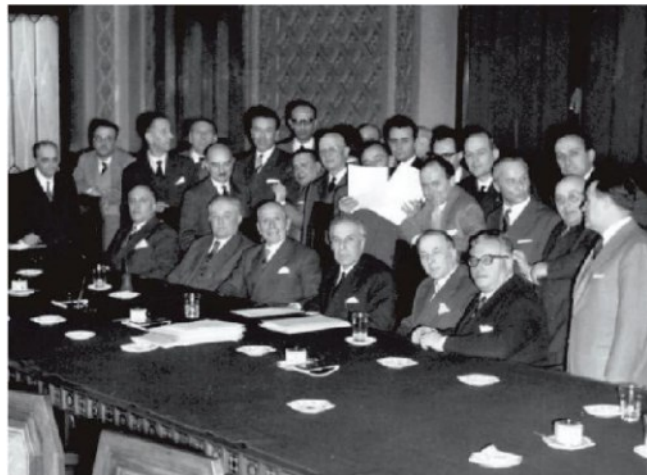
9 giugno 1952: la firma che ha fatto nascere la A4 Padova-Brescia
