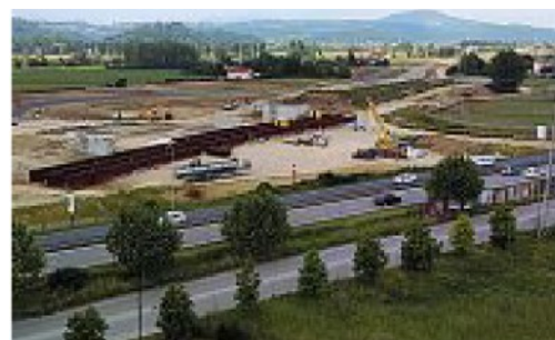
Cantiere I lavori alla tangenziale visti da via Montale
