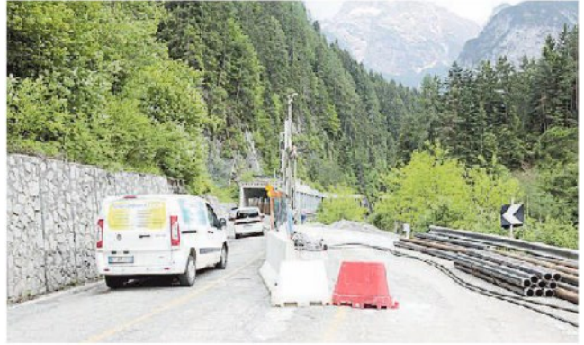
Un cantiere lungo la 51 bis
