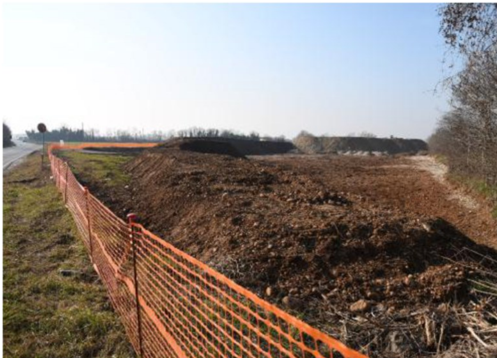
Un altro cantiere per la linea ferroviaria ad alta velocità a Castelnuovo del Garda
